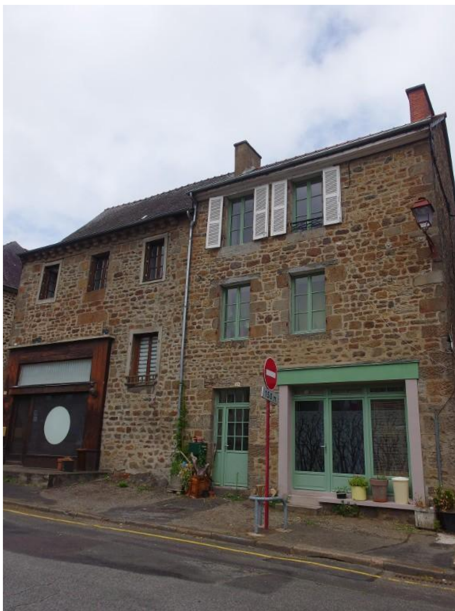
Vue de la façade est
