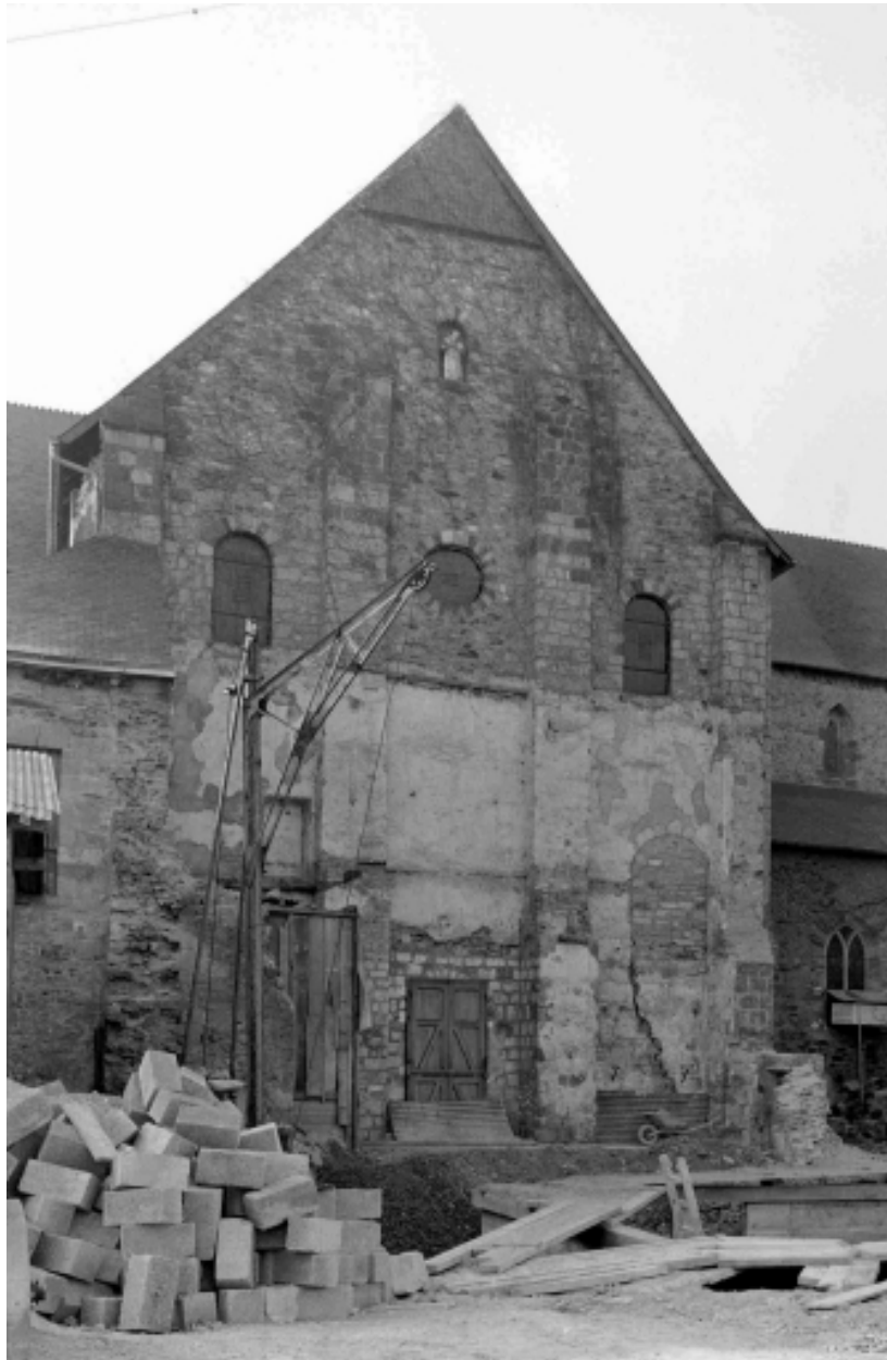
Détail sur la façade sud du transept
