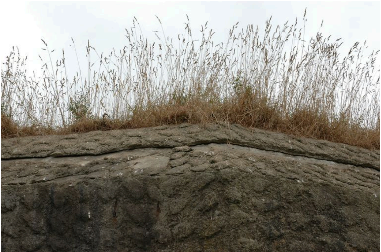
Vue du bunker-casemate nord : détail du traitement texturé du béton à des fins de camouflage (état en 2008)
