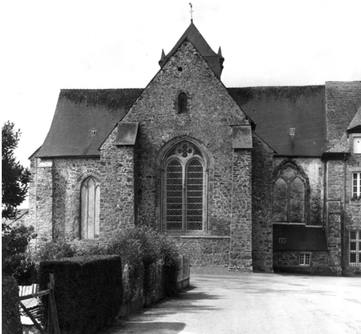
Eglise ; chevet, vue de situation
