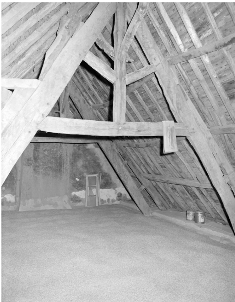
Charpente : vue générale
