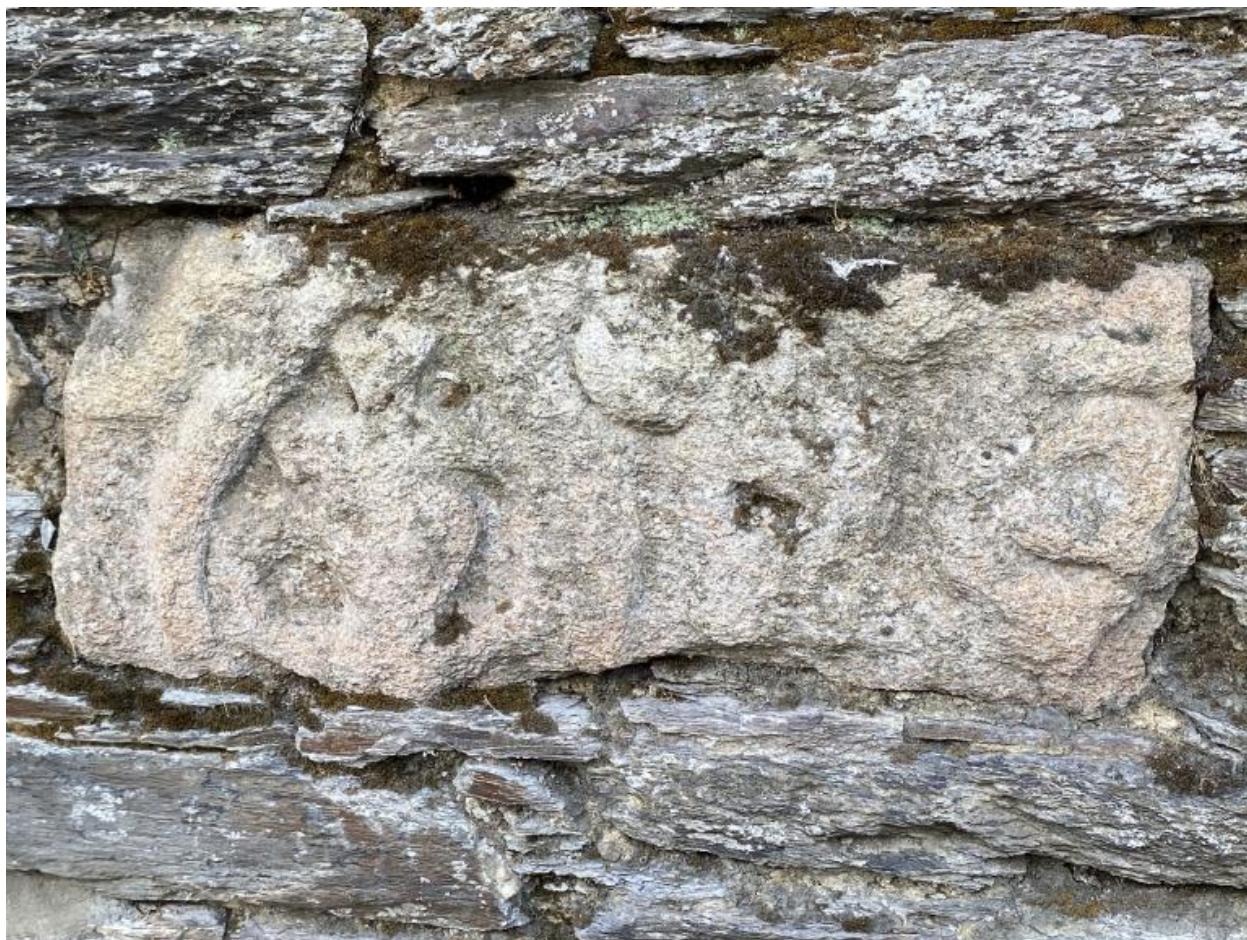
Pierre sculptée sur le mur d'enceinte, vue sud
