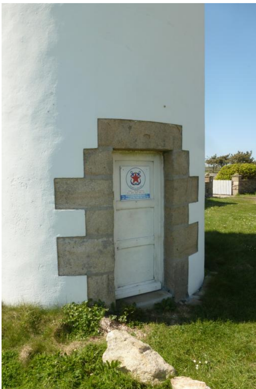
Détail de la porte d'entrée côté nord.
