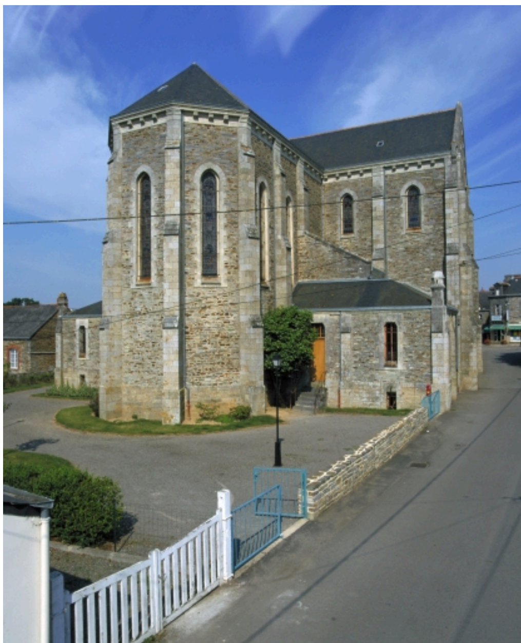
Vue générale sud
