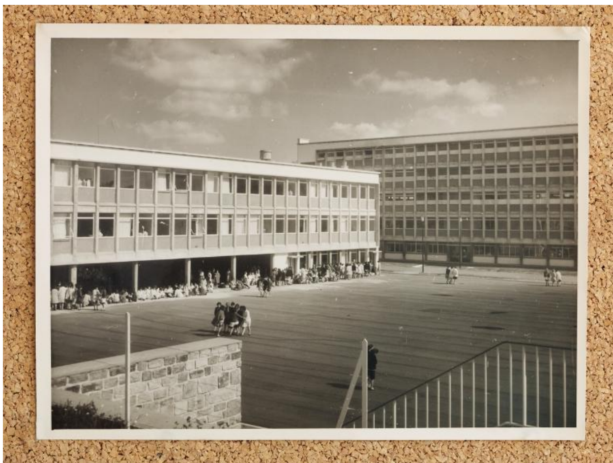
Bâtiment B et C. Élèves dans la cour et sous le préau.
