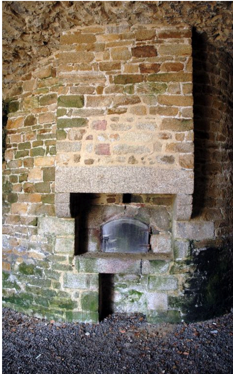
Vue de la citadelle de Port-Louis : four à pains aménagé dans une casemate du rempart
