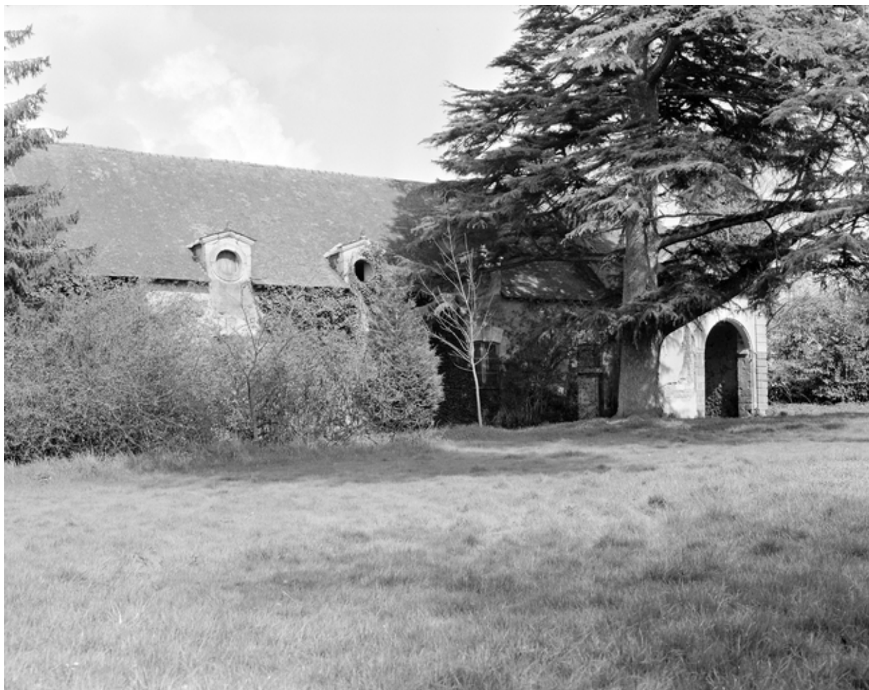
Communs, vue générale sud.
