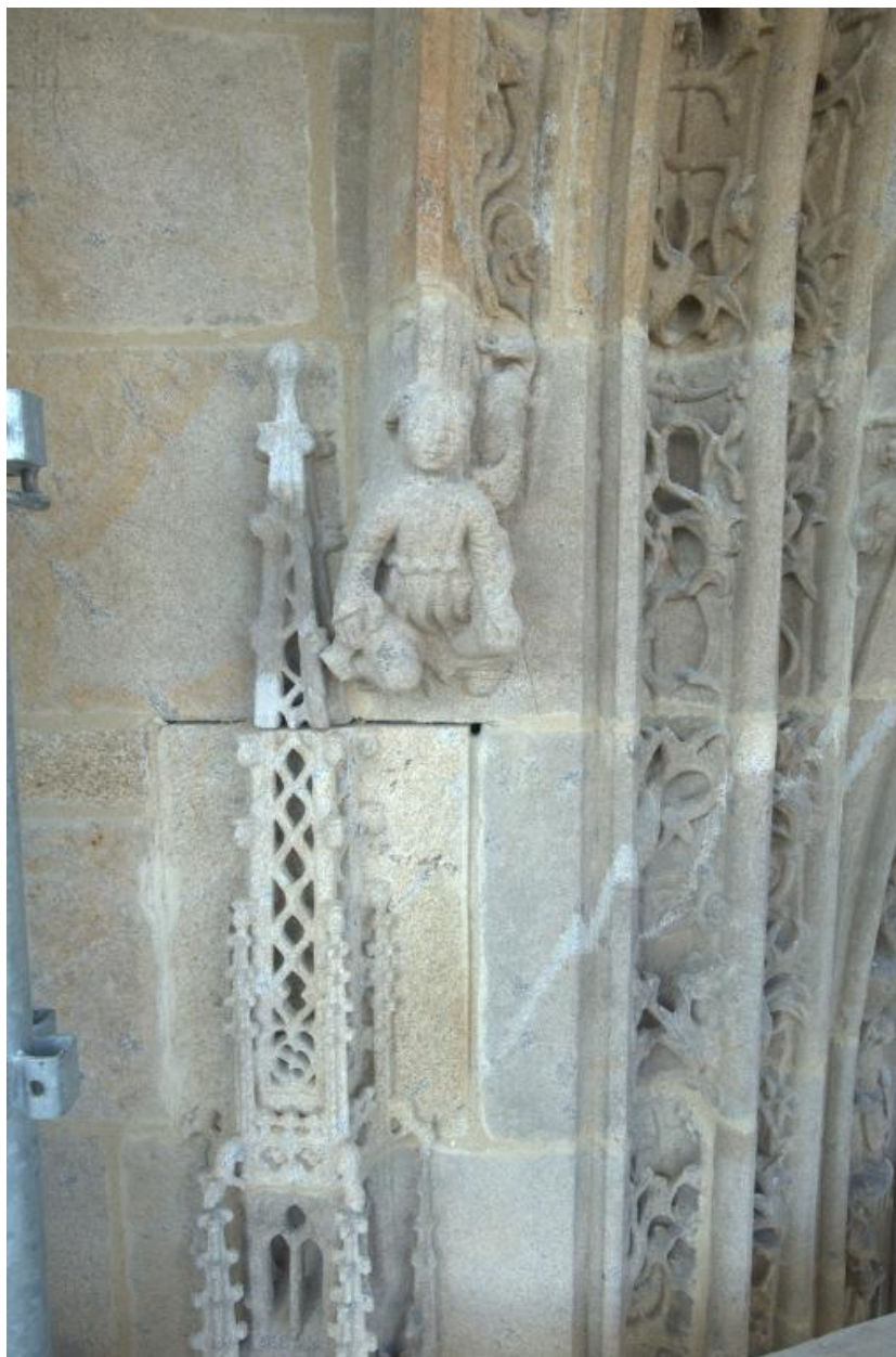
Portail nord. Vue d'une greffe de restauration
