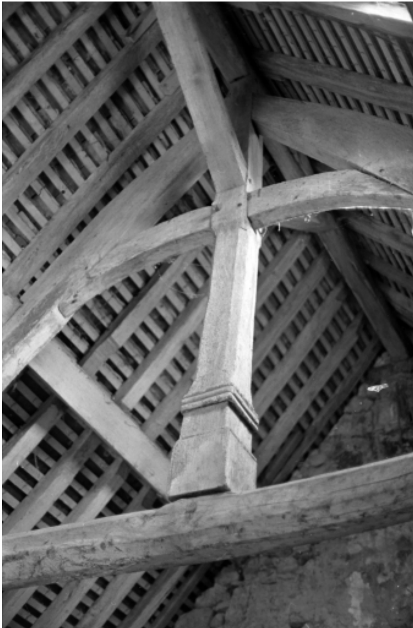
Chapelle : détail pignon et entrait
