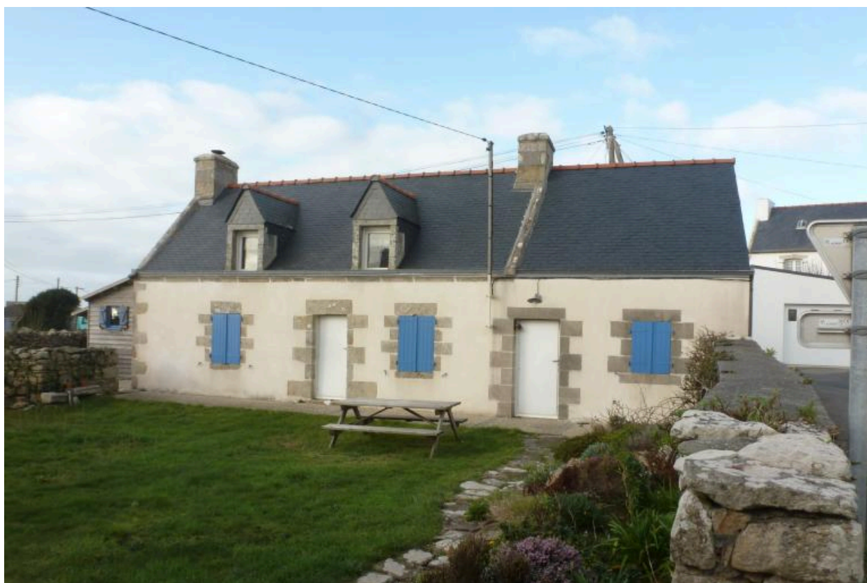
Maison 11, élévation antérieure du logis et de la crèche accolée. (façade remaniée)
