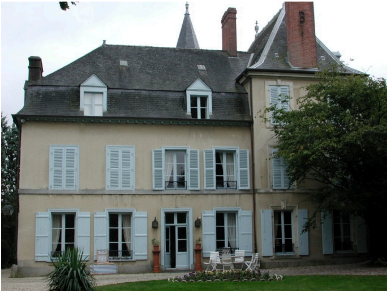
Vue générale de la façade principale
