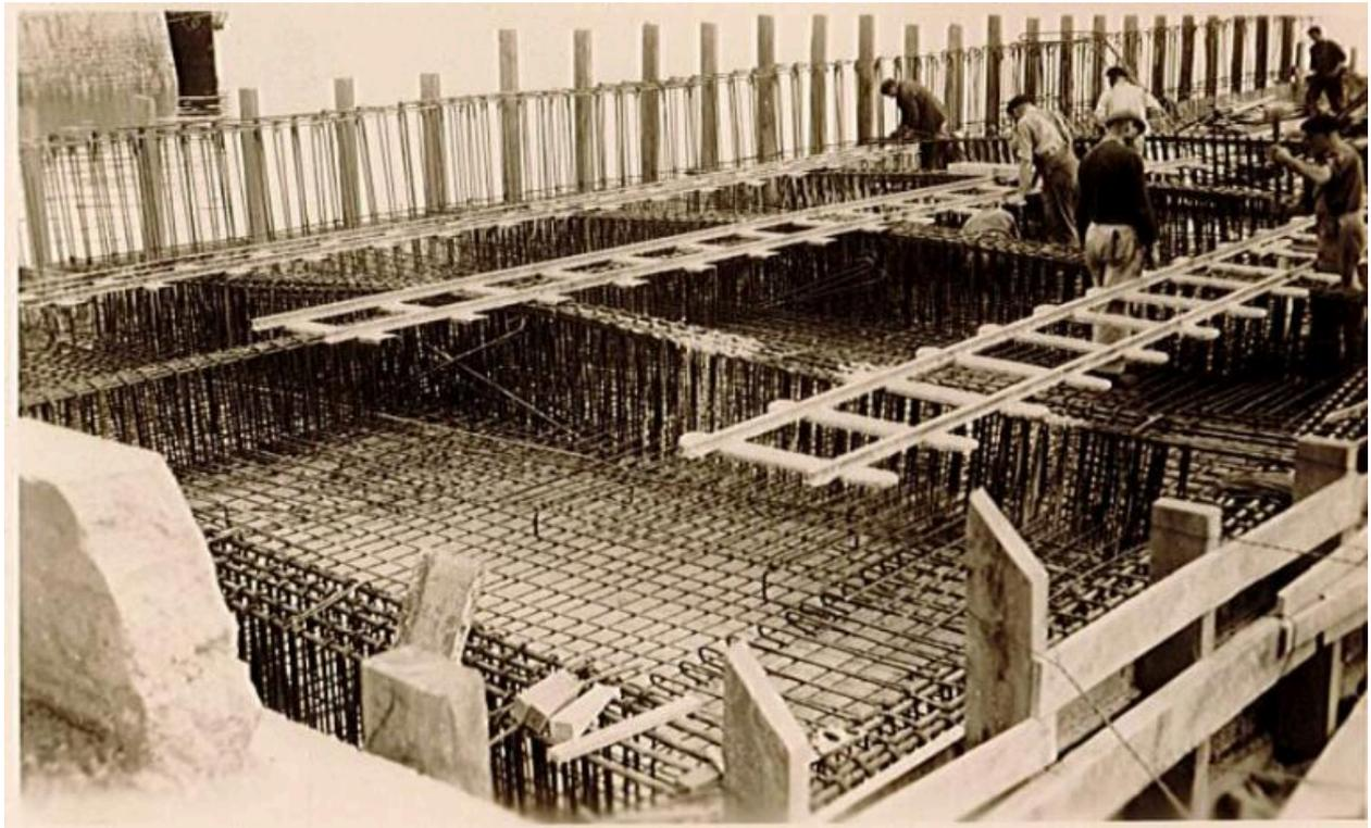
Photographie de suivi de chantier, ferrailage de la dalle du quai ouest ; coffrage
