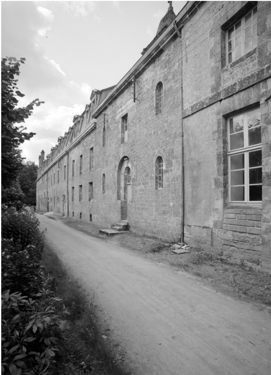
Corps de bâtiment D, chapelle, façade est (1965)
