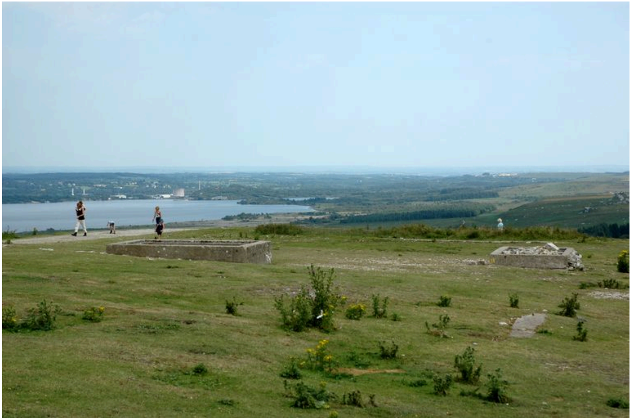
Vue de deux bunkers en construction de campagne (état en 2004)
