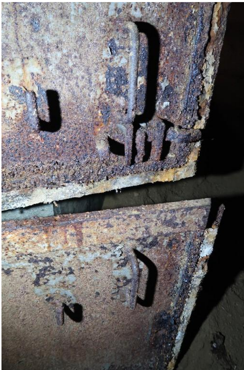
Vue de détail de la porte blindée à deux vantaux du sas (côté sud) : poignées des vantaux et système de fermeture
