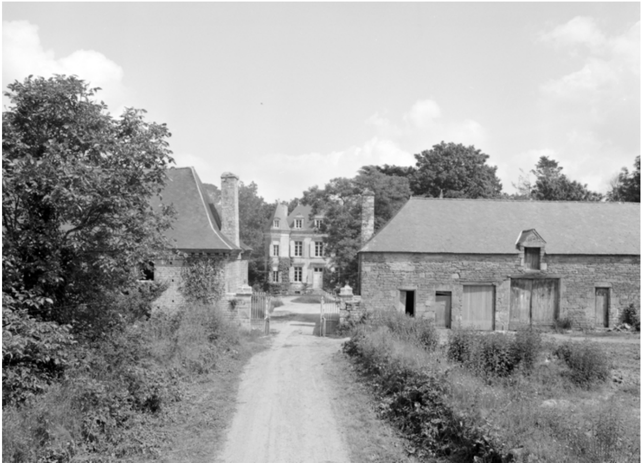
Vue de situation prise du sud.
