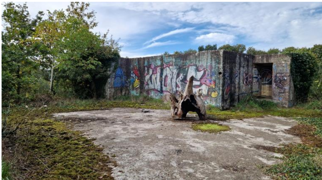
Vue de l'accès à la cuve du télémètre depuis la dalle de couverture
