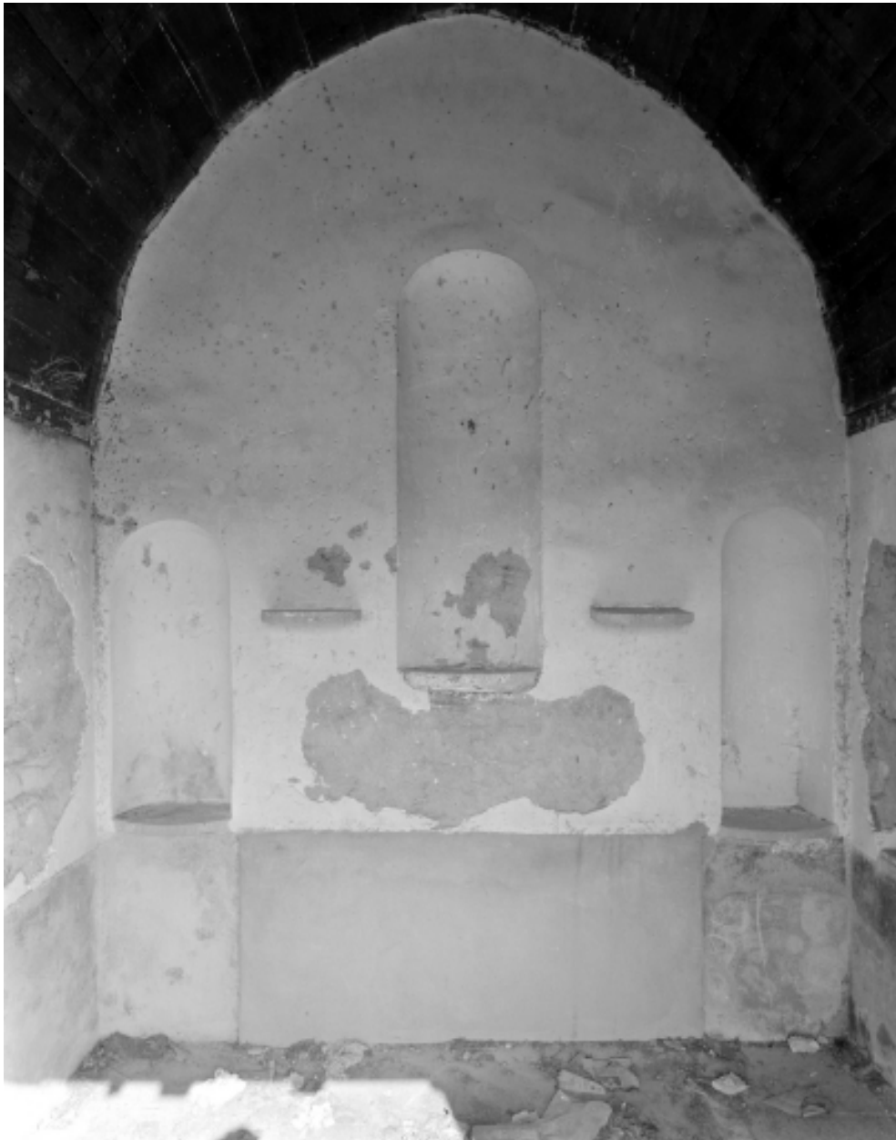
Intérieur, chœur, niches : vue générale
