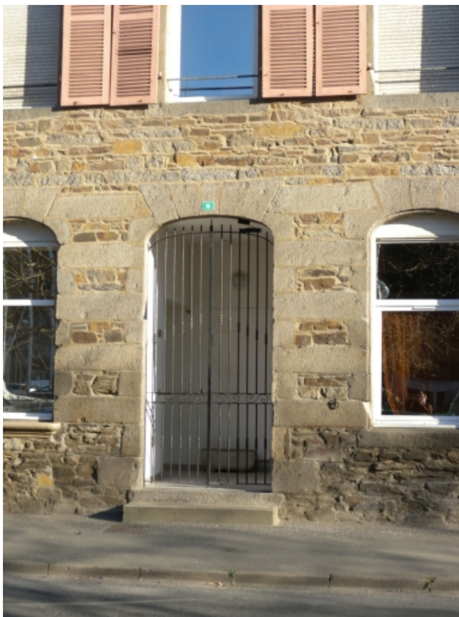
Vue de l'une des portes d'entrée de l'immeuble, avec son arc de décharge : la façade en moellons de schiste et les encadrements en pierre de granite
