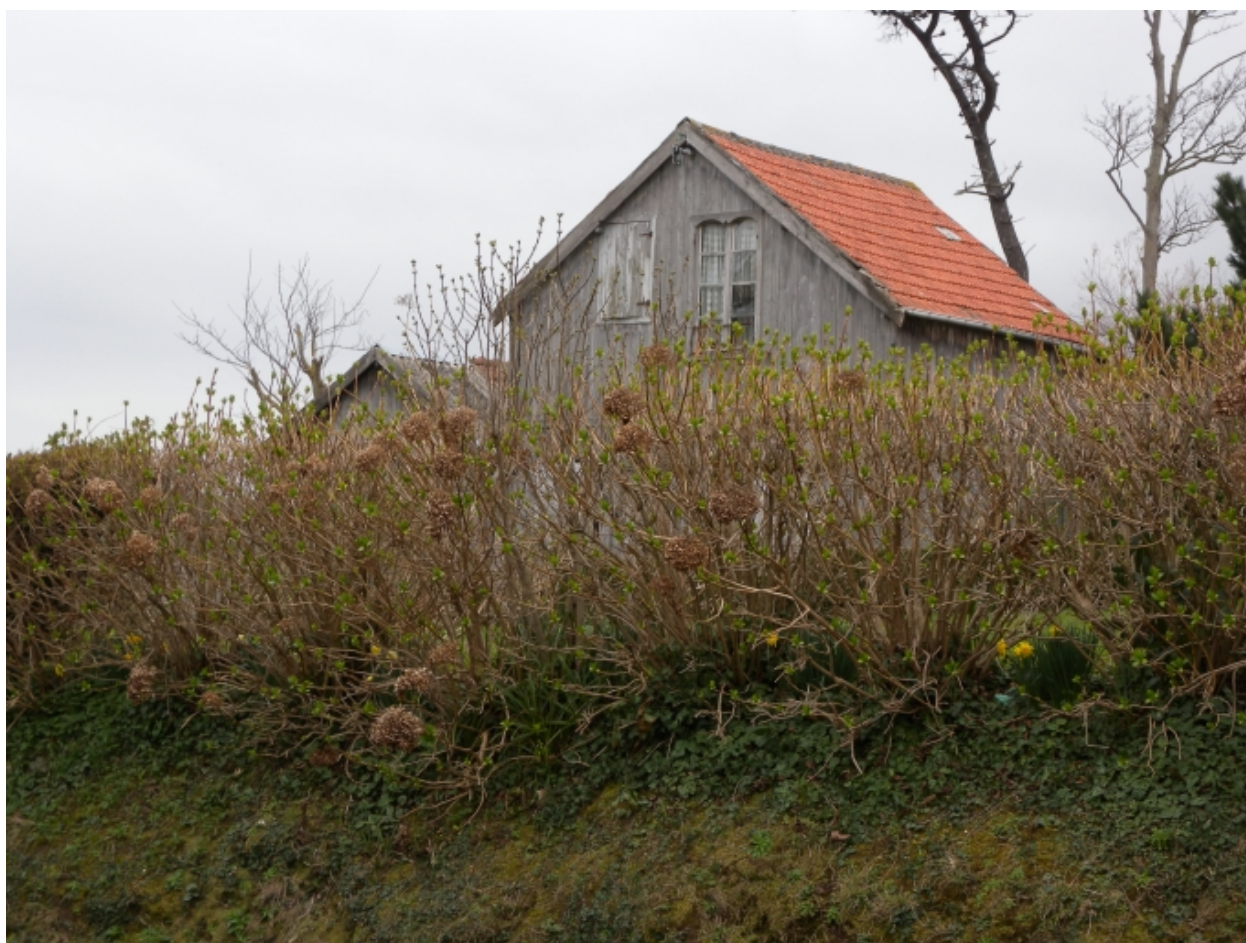
Maison du type chalet en bois, datée du début du 20ème siècle, en front de mer
