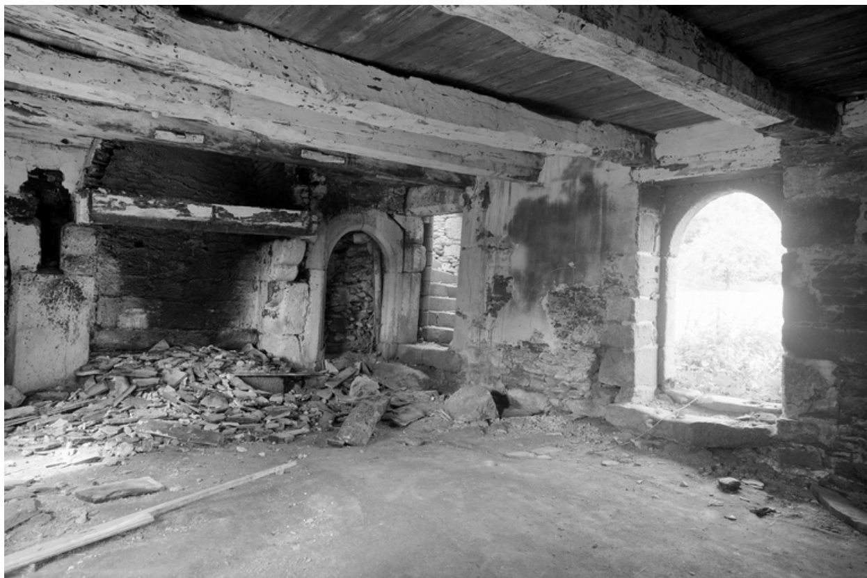
Pièce à l'est, rez-de-chaussée : vue de l'angle nord ouest
