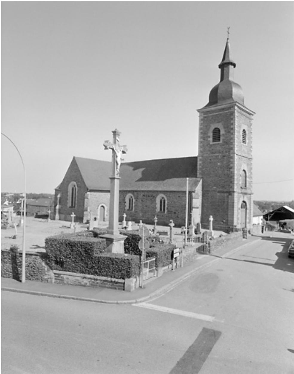
Elévation Nord-Ouest : vue générale.
