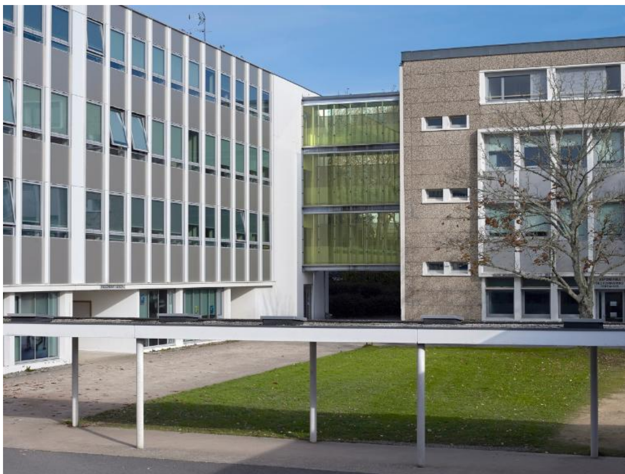
Jonction entre le nouvel internat P3, à gauche, et le bâtiment scientifique.
