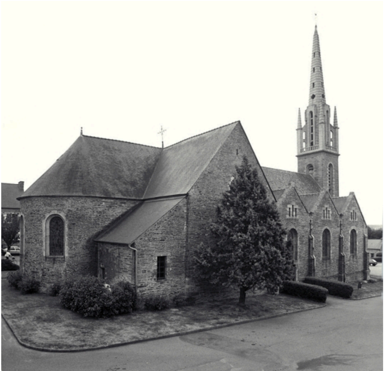
Elévation ouest : vue générale
