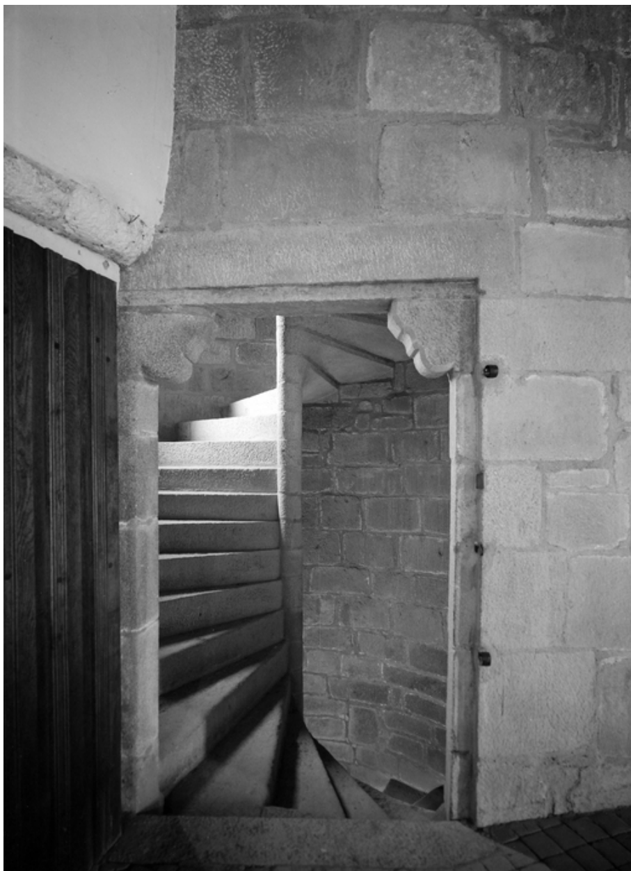
Vue de l'escalier en vis (état en 1974)
