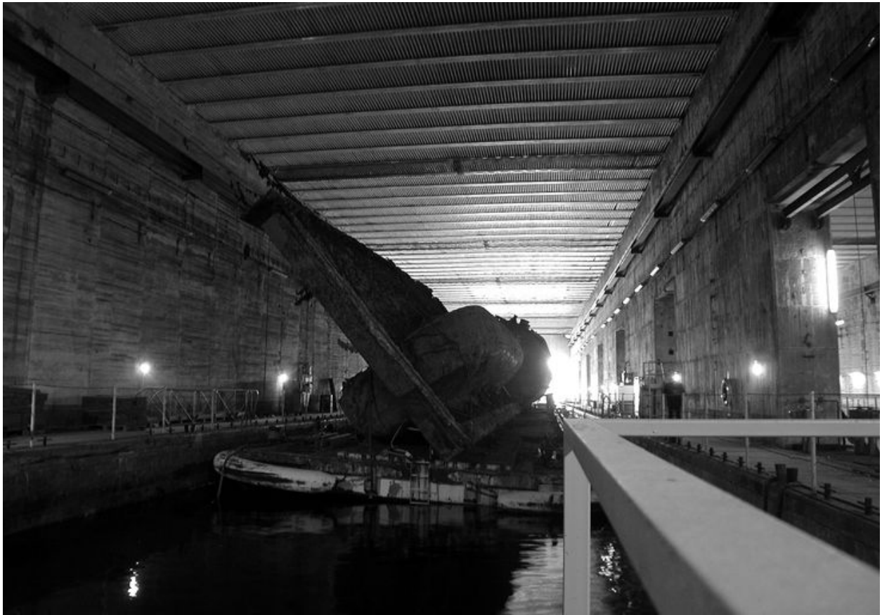
Vue intérieure de la base de sous-marins : alvéole à flot, bateau porte en attente sur une barge (2004)
