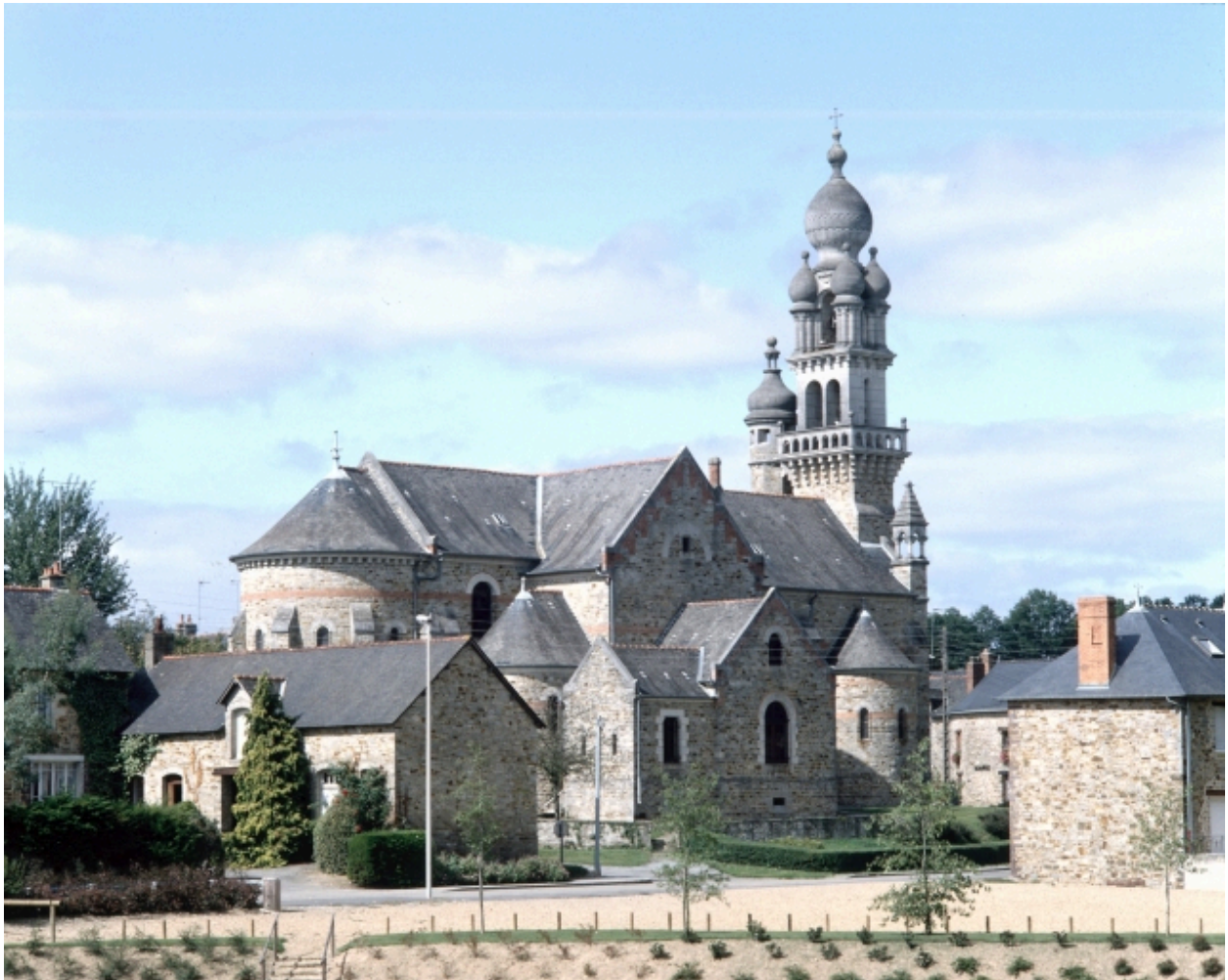
Elévation Sud-Est : vue générale
