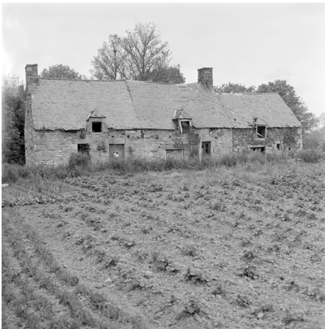
Traon an Goas - Ferme II, façade sud : vue générale (état en 1974).
