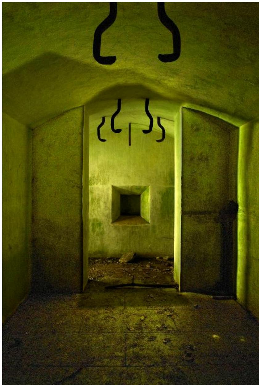
Vue intérieure du magasin à munitions (vers l'entrée) : vestibule d'entrée et créneau à lampe. Il conserve du matériel de second oeuvre : fixations du rail pour la manutention des obus par un palan
