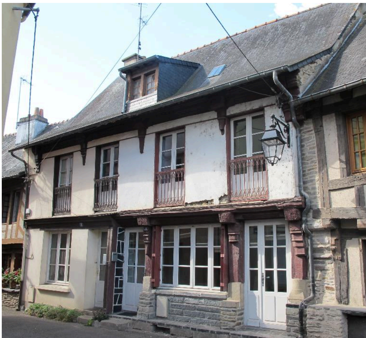
Maison : élévation est (état en 2012)
