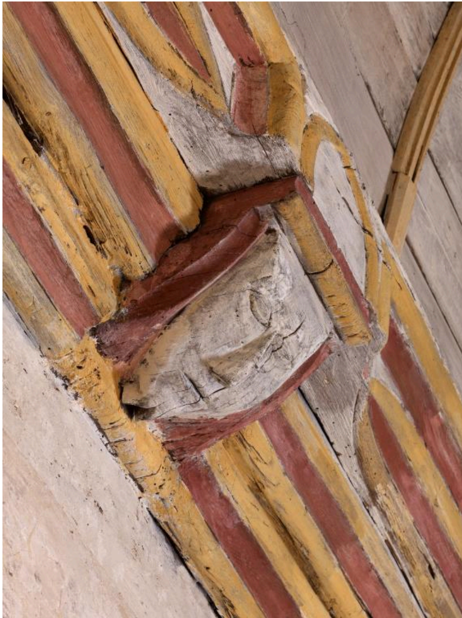
Eglise Saint-Melaine, détail de la charpente de la sacristie Saint-Gilles
