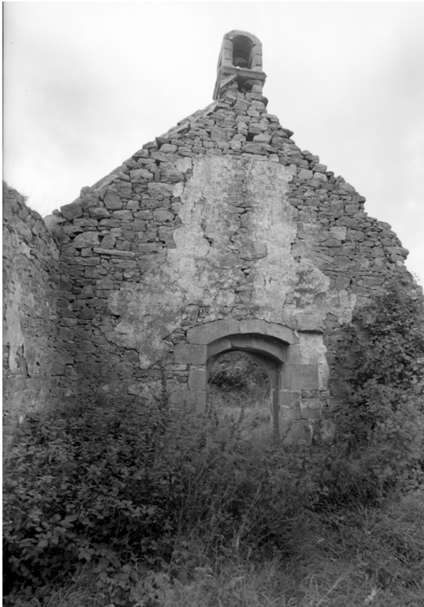
Vue générale du revers du mur ouest
