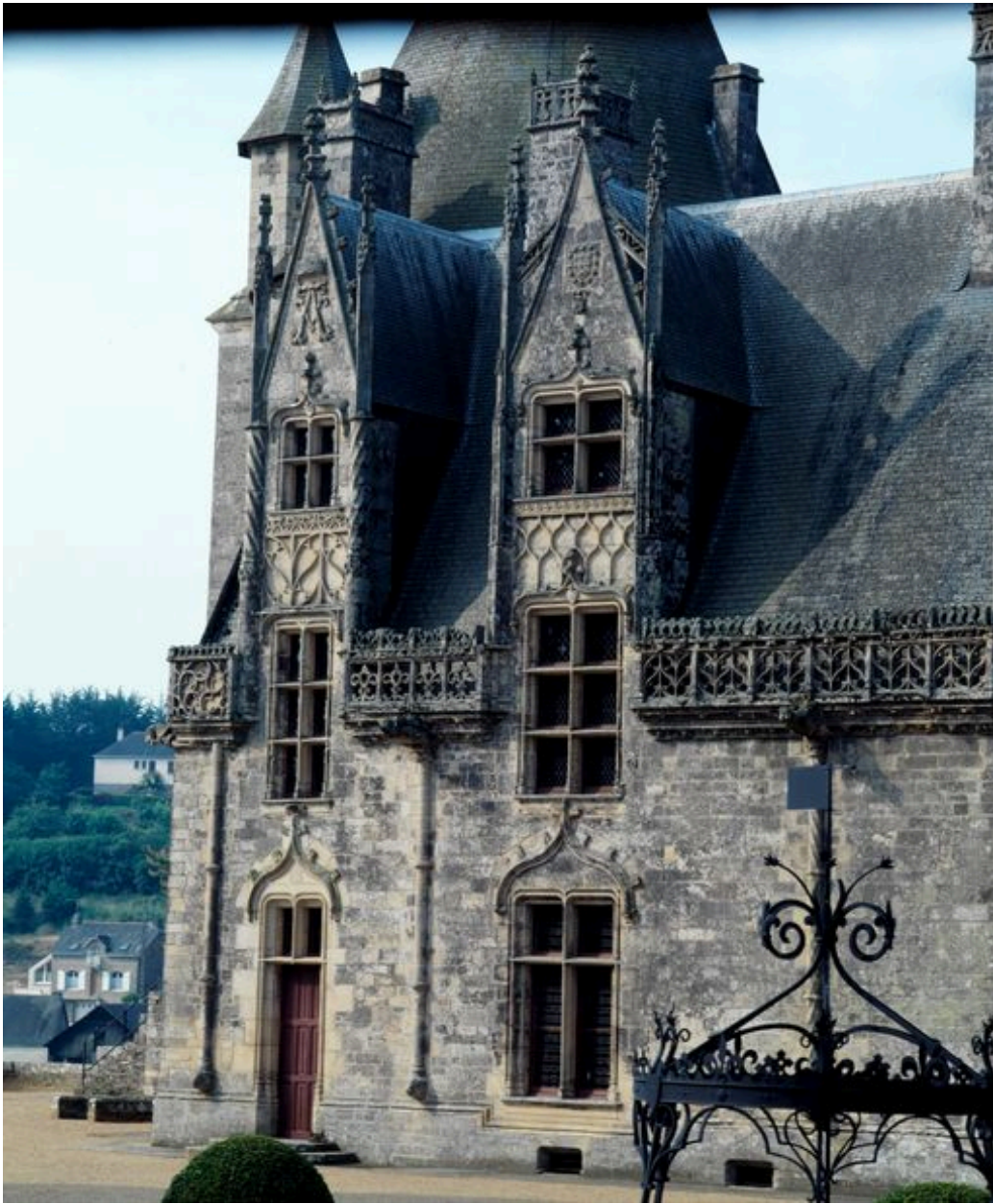
Logis, élévation sur cour : les deux premières travées à partir du sud
