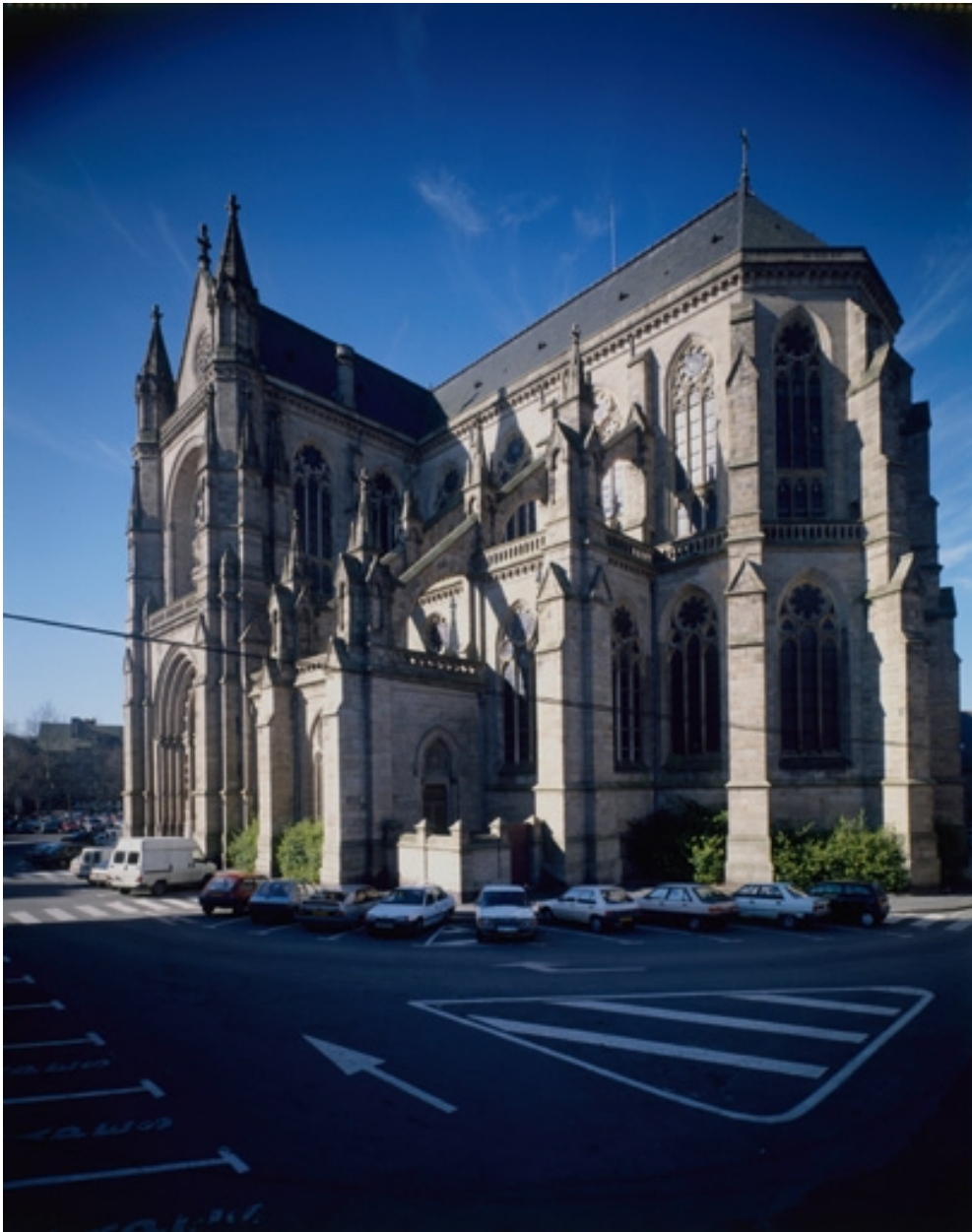
Elévation sud est : vue générale
