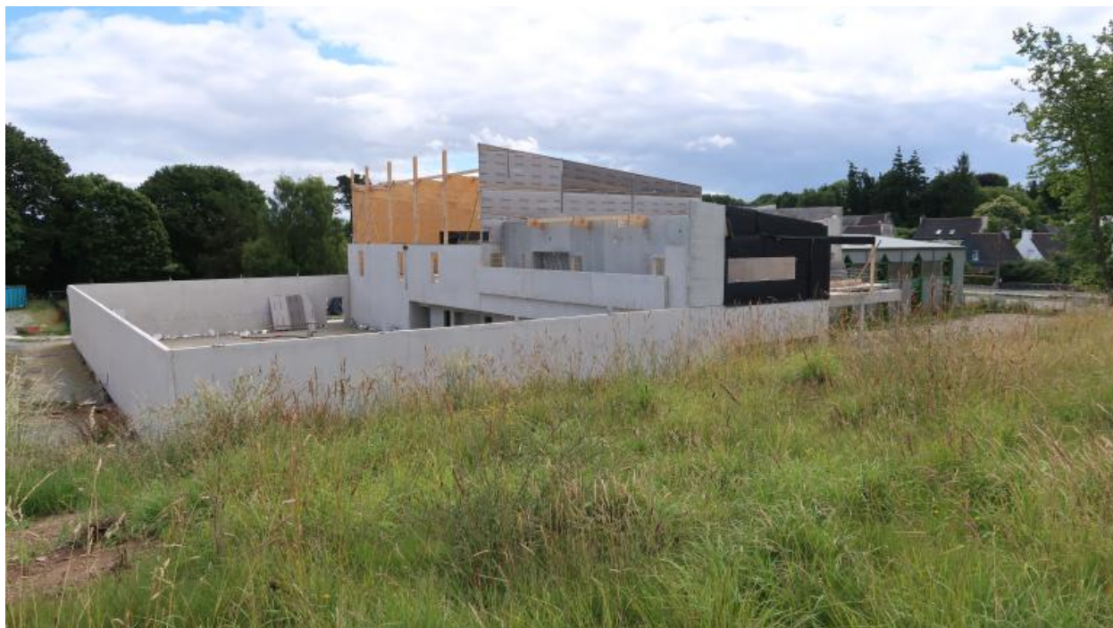
Le nouveau gymnase en construction, le 27 juin 2022.
