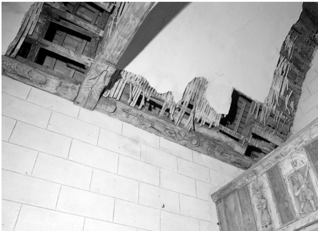
Sablières, mur sud.
