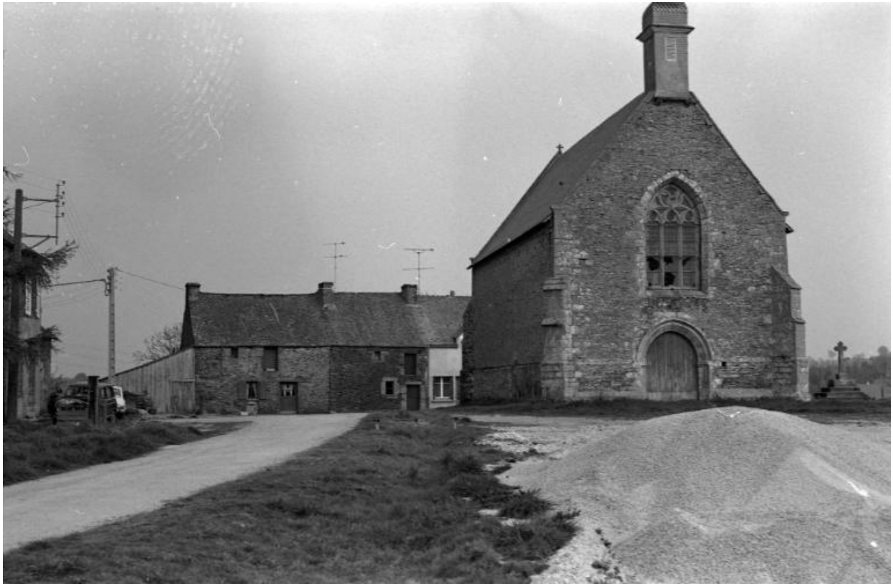
Vue générale de la façade ouest
