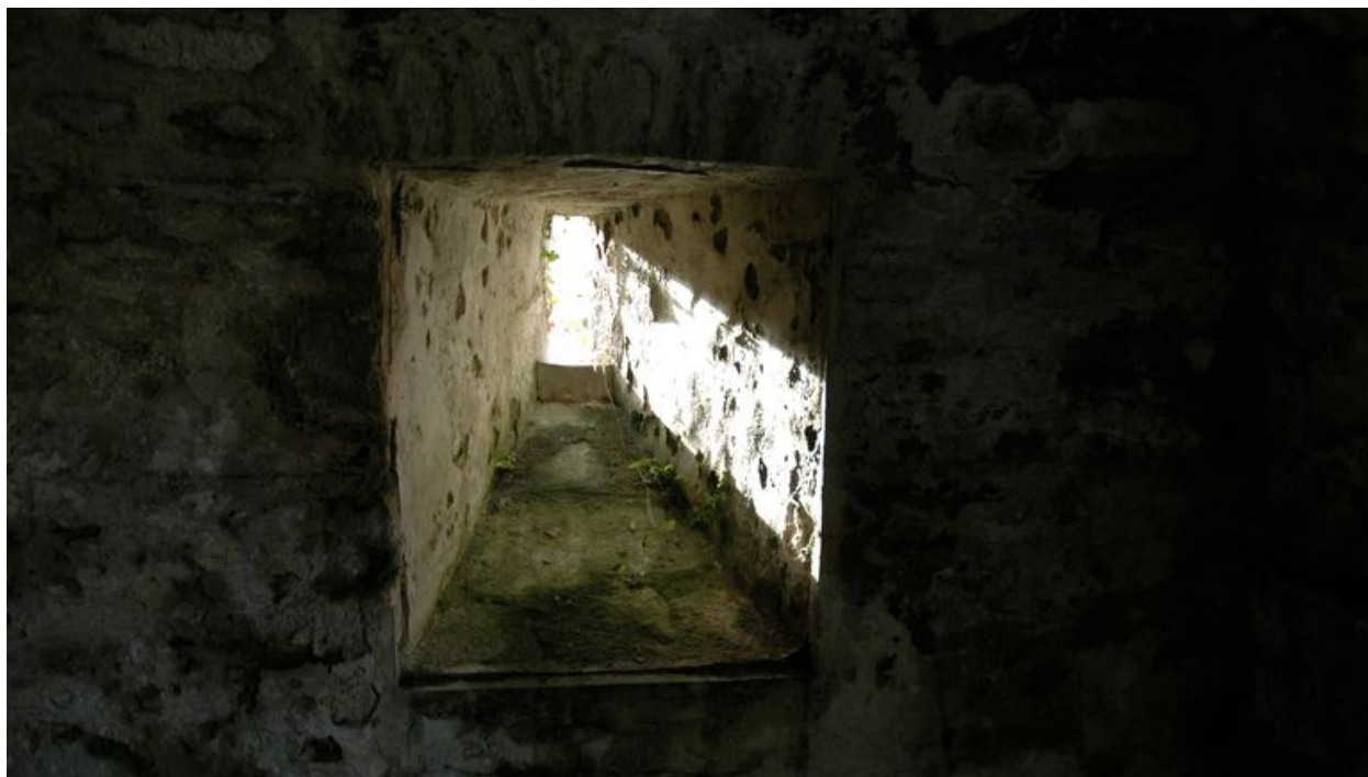
Vue intérieure : créneau de tir permettant la défense du fossé sec (état en 2004).
