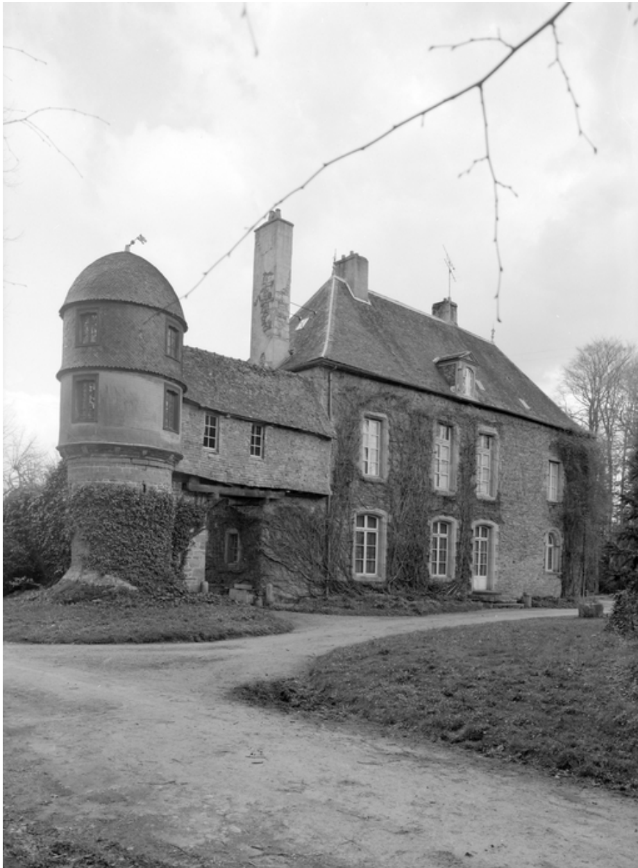
vue générale ancien corps d'entrée
