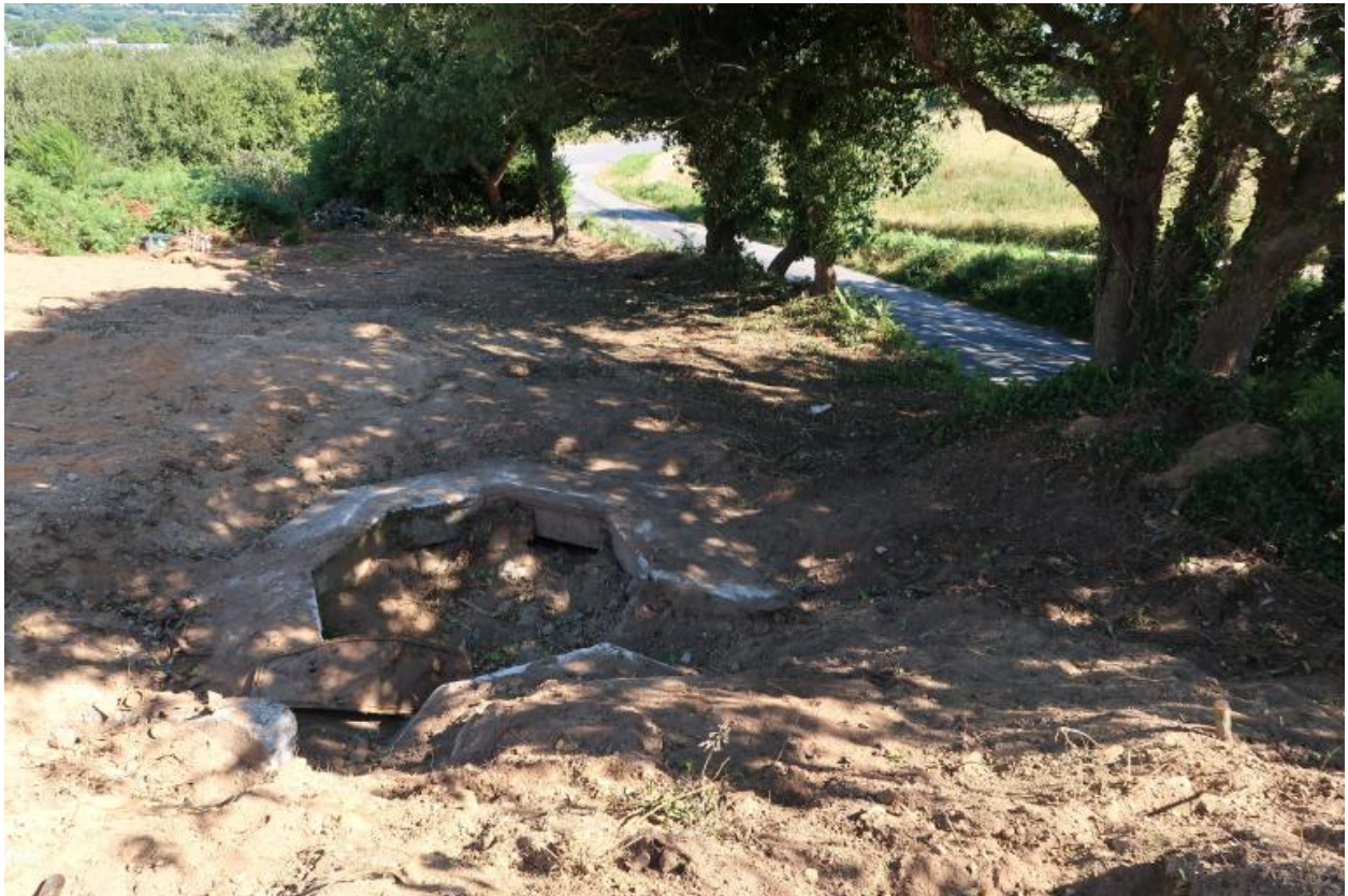
Vue de situation (août 2022, chantier en cours)
