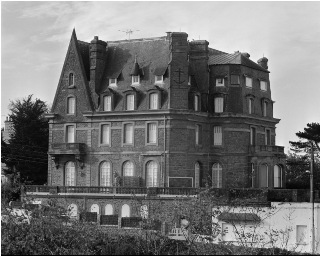
Vue rapprochée de la façade postérieure nord et de la façade latérale est du logis..
