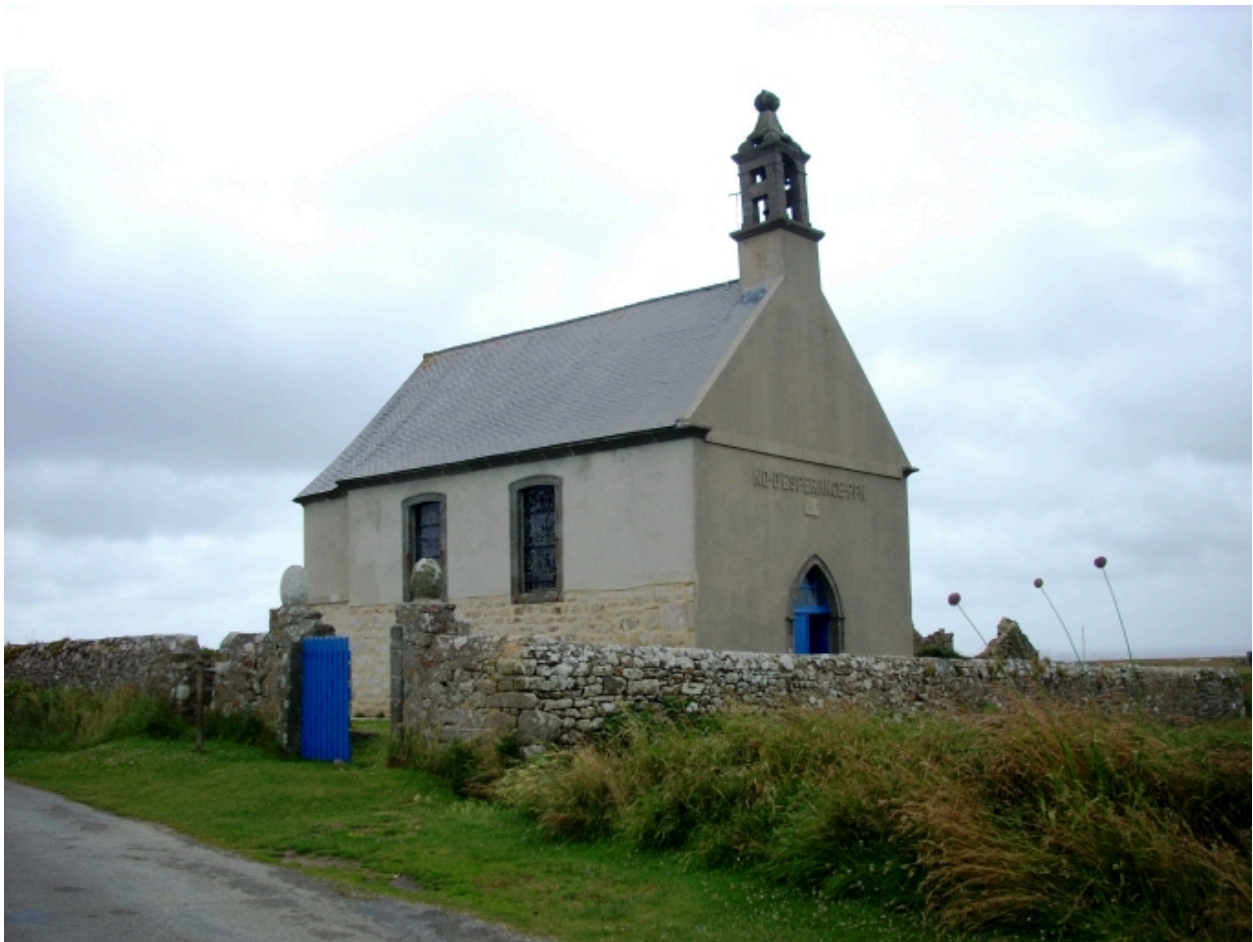
Ouessant, chapelle de Ker Ber : vue générale nord-ouest
