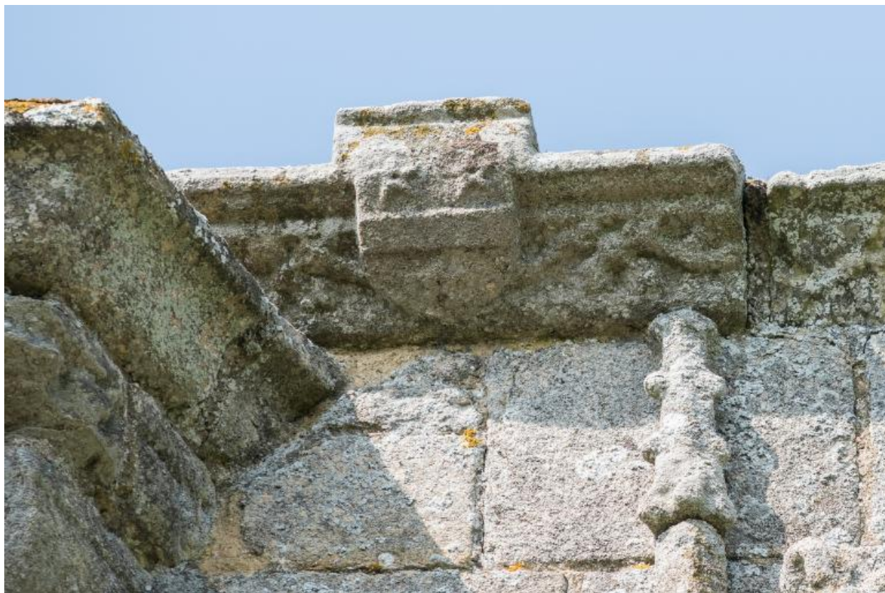
La château, partie haute de la tour d'escalier : corniche sculpté portant les armoiries de la famille Ferré
