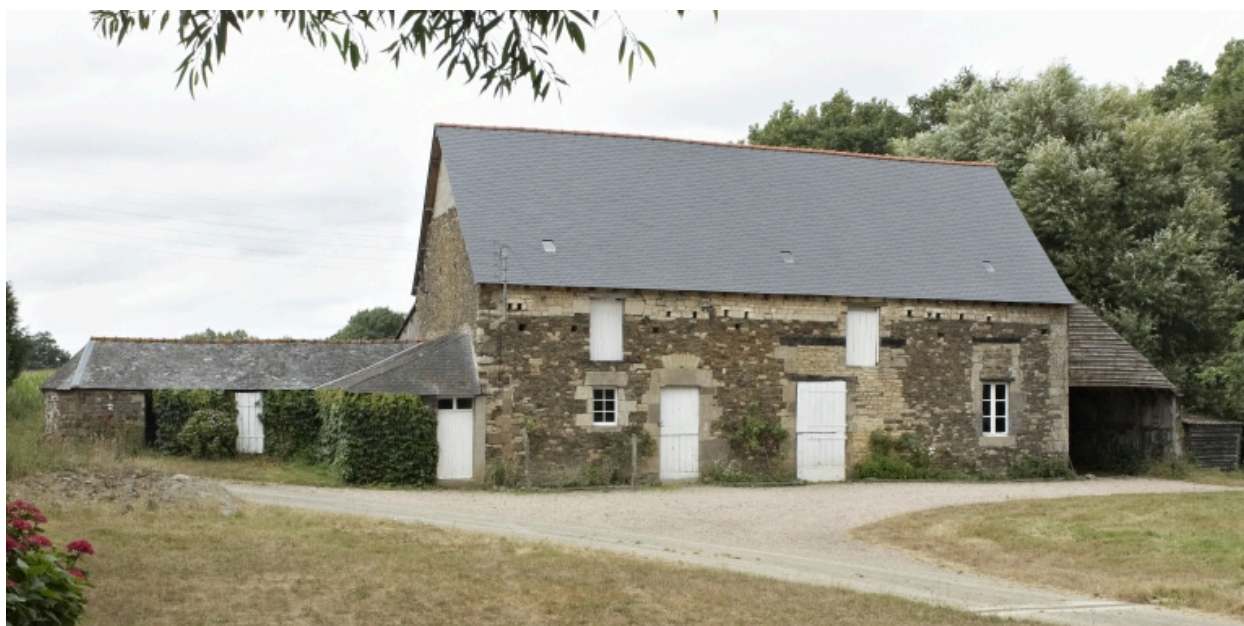
Vue générale de la grange
