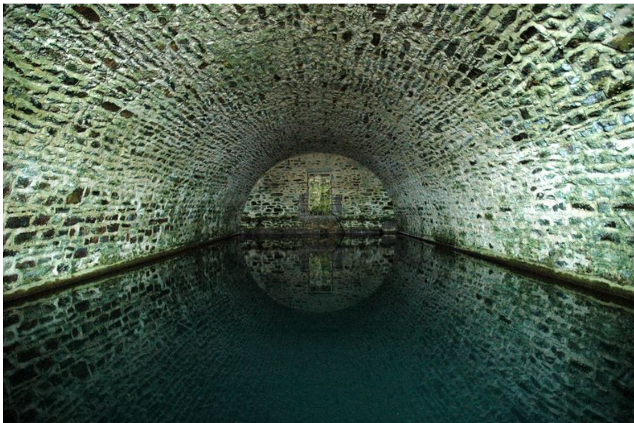
Vue de l'aiguade de la Belle-Fontaine : intérieur
