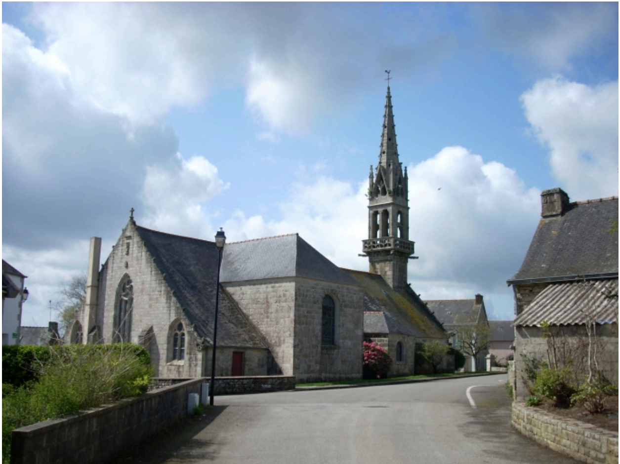
Langolen, église paroissiale Saint-Gunthiern : vue générale nord-est
